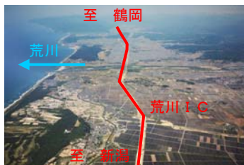
日本海沿岸東北自動車道
