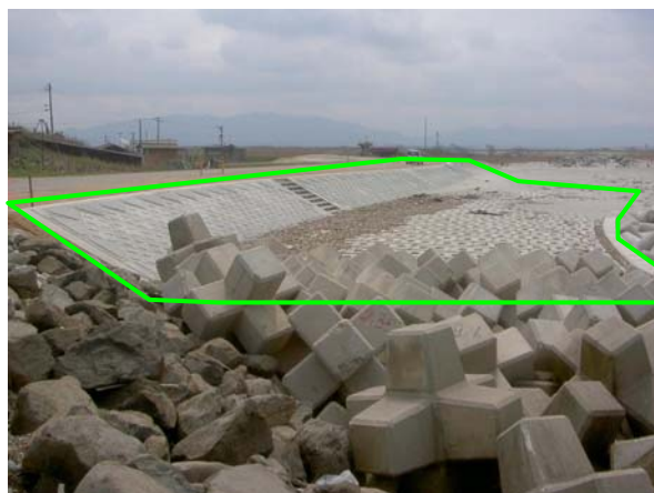
護岸整備状況
