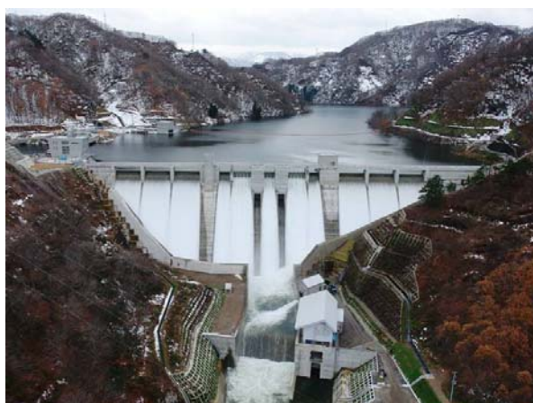
H19. 12横川ダム試験湛水状況
